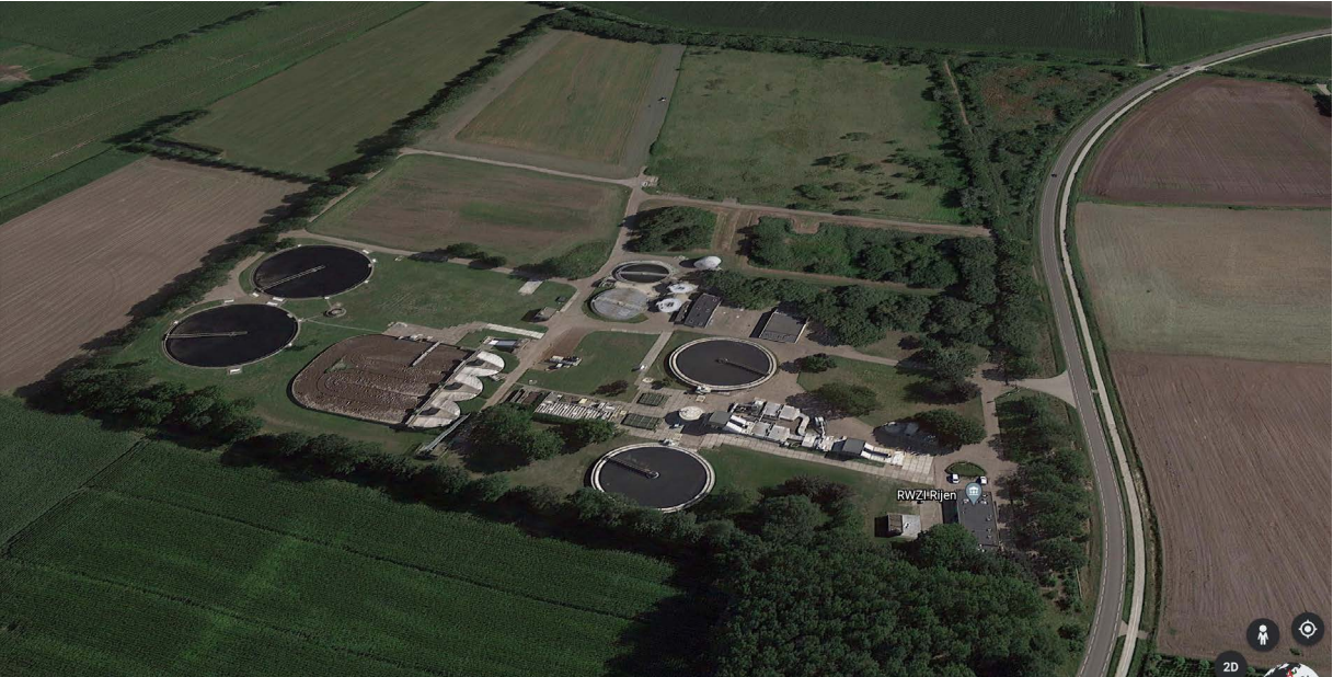
Luchtfoto rioolwaterzuiveringsinstallatie in Rijen (Google Earth)
